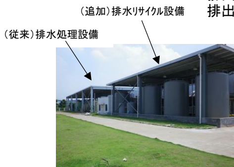
メッキ工場排水リサイクル設備
