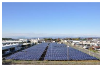
群馬太陽光発電所
