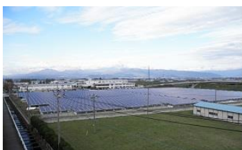
南アルプス太陽光発電所
