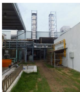
塗装工場排気処理設備
